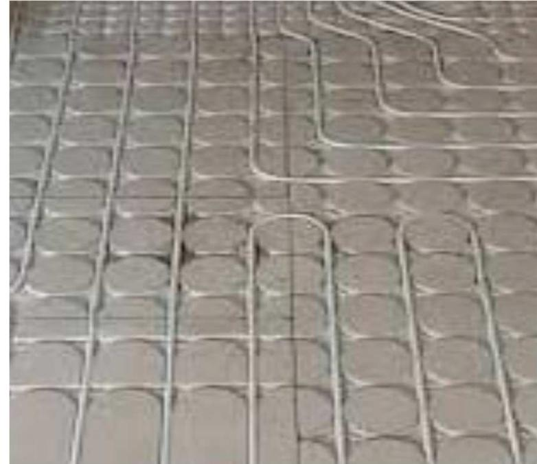
Una volta inserito il tubo verificare la necessità di applicare una leggera pressione se si presenta leggermente sollevato dalla superficie della lastra. Può essere utile anche un martello in gomma o materiale che non danneggi il tubo.
