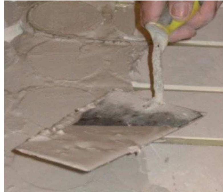
Si riempiono le scanalature e le parti con bugne per creare un piano liscio per l'incollaggio della finitura.
